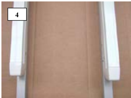
4 Côté avancée de la coulisse de guidage avec galet de renvoi et coiffe de coulée.
