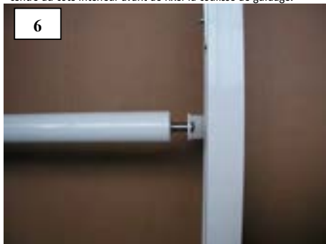
6 • Découper l'arbre de soutien de toile après avoir défini la position de la coulisse de guidage/la distance entre les coulisses de guidage. • Monter l'arbre
