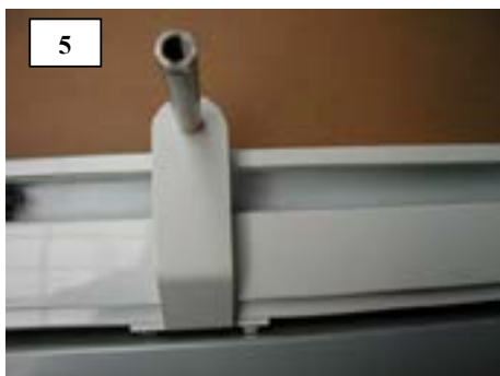
5 • À partir de certaines largeurs ou avancées, le montage d'un soutien de toile s'impose. • Pour ce faire, il faut installer le support du soutien en saillie et au centre du côté intérieur avant de fixer la coulisse de guidage.
