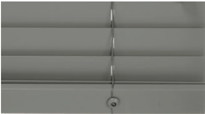
Befestigung der Leiterschur an der Unterseite
