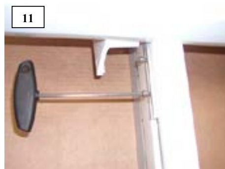
11 Fahren Sie das Ausfallprofil bis zum Laufwagen (ca. 40 cm) vor und drehen die vormontierten Schrauben heraus.
