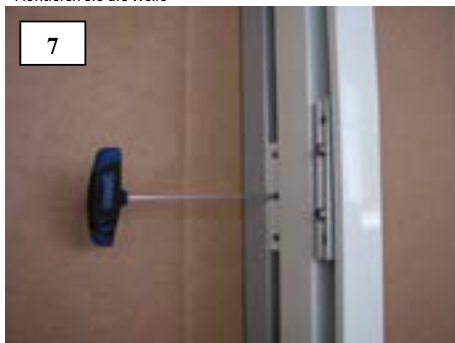
7 • Setzen Sie die Führungsschienen auf und ziehen alle Schrauben am Halter (3xlinks, 3xrechts je Halter) gleichmässig fest (Innensechskantschlüssel Gr.3). • ACHTUNG! die Laufwagen befinden sich immer auf der linken Seite der Führungsschienen.
